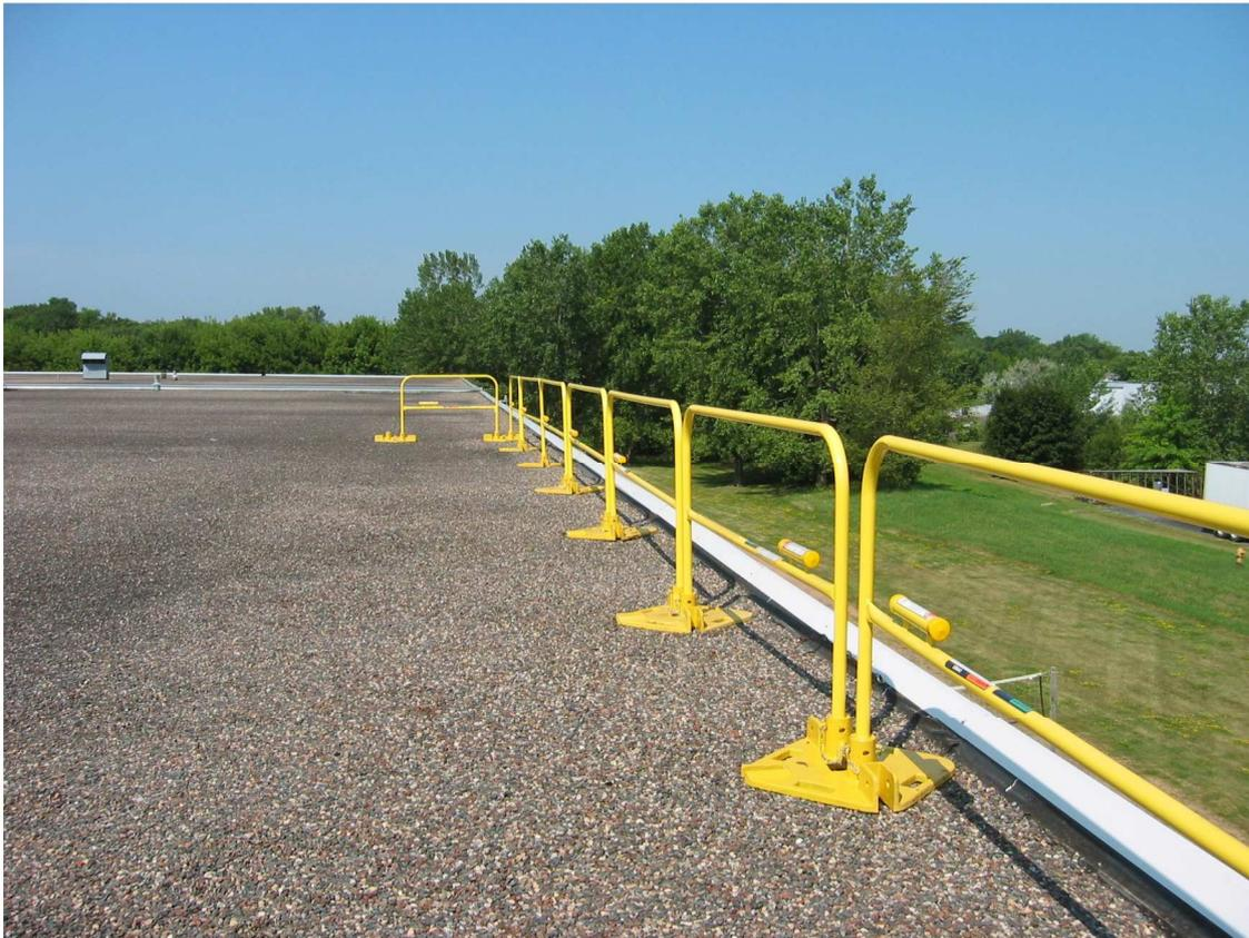
Un système de protection contre les chutes sur le bord des toits est essentiel pour éliminer les blessures et sauver des vies.
